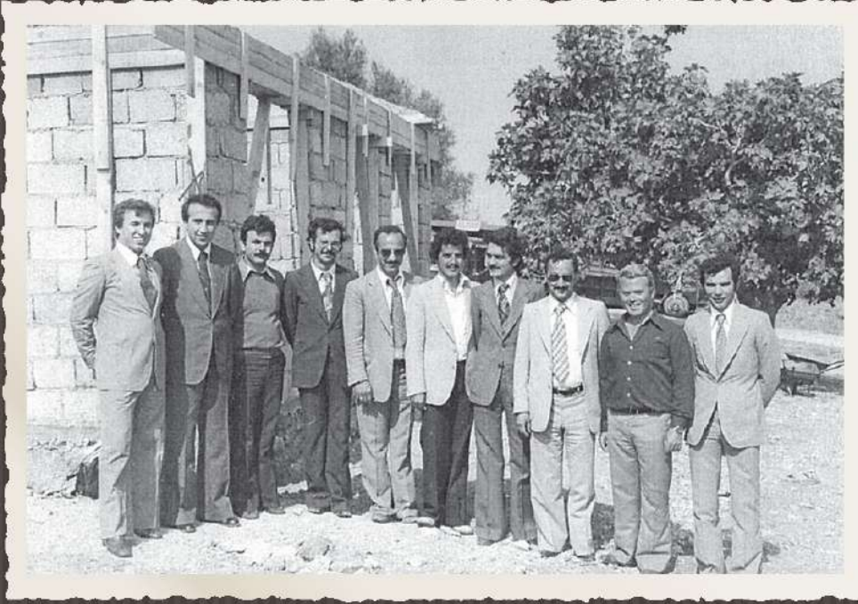
1975 İZMİR DEMİR ÇELİK SANAYİ A.Ş. İNŞAAT ALANI ŞANTIYE BİNASI ÖNÜ
